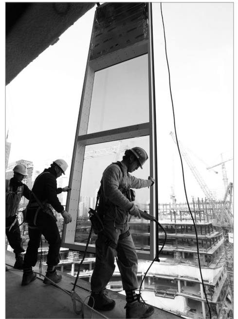
커튼월 시공 현장.
